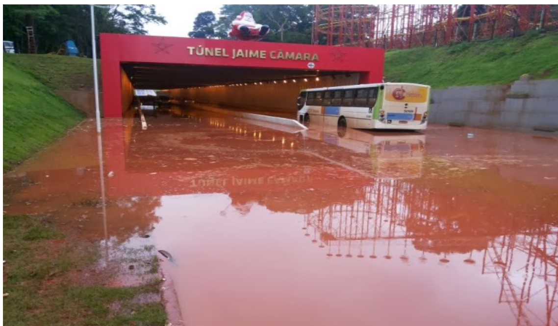
Figura 3: Túnel da Avenida Araguaia alagado, Goiânia, GO, 2013
